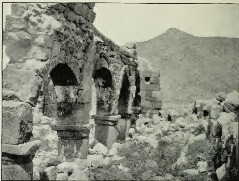
FIG. 27.—No. 5, S. aisle, looking E.
